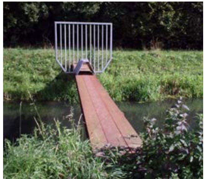
Dassenoversteek in de vorm van een loopplank met hek (om mensen te weren)
