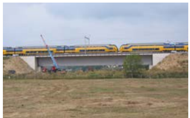
Brede onderdoorgang onder spoor (Bron: ProRail)
