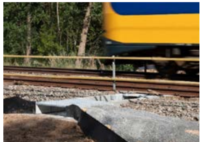
Toeloopt en ingang van een dwarsligger faunapassage (Bron: Movares)
