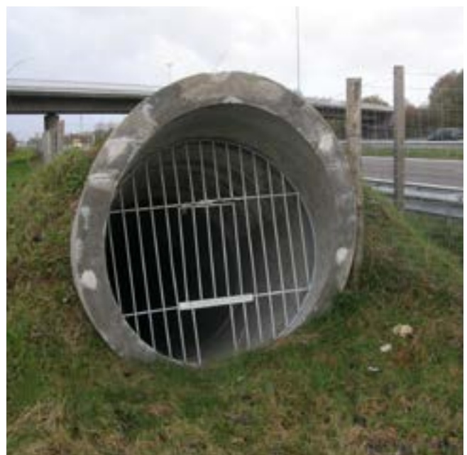
Rooster voor ingang faunatunnel bij de A58 om te voorkomen dat er kinderen inkruipen
