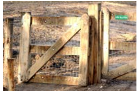
Vanzelf dichtvallend poortje voor wandelaars
