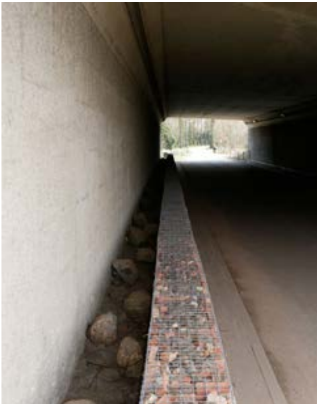
Een schanskorf als dekking-gevende steenwal
