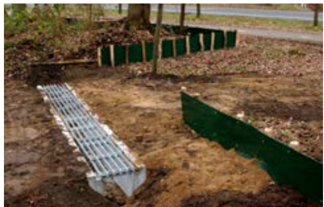
Kunststof is alleen geschikt voor tijdelijk schermen. Let op dat de palen aan de wegkant van het scherm staan
