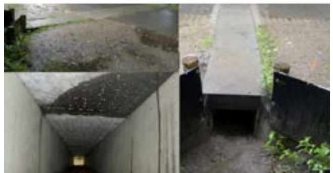
Een CAT-tunnel onder de Dochterenseweg in Lochem (Bron: Kies 2012)
