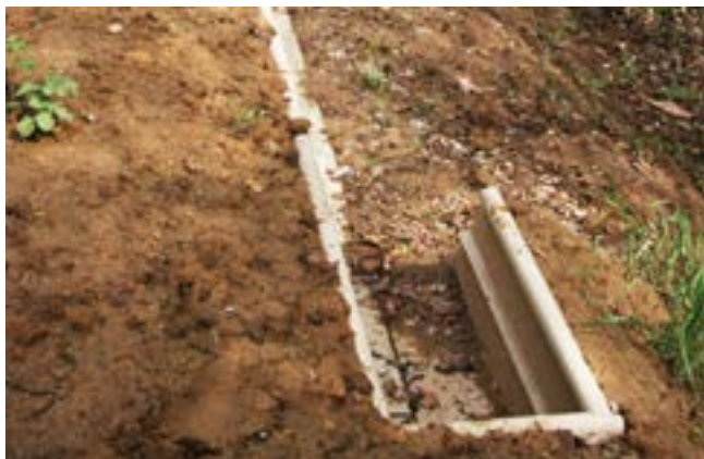
Aan het einde van stalen geleidewanden worden vaak U-vormige constructies toegepast (Bron: ACO)
