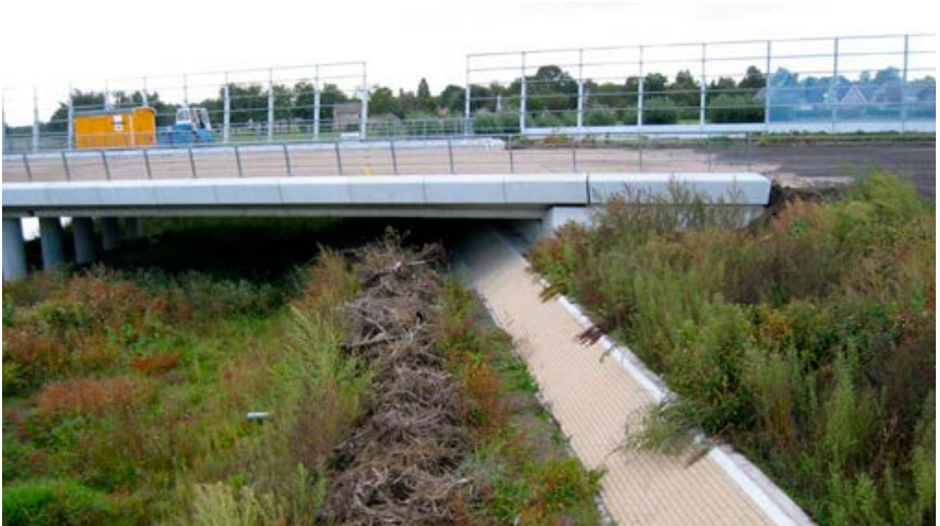
Nieuwe stobbenwal onder het spoor (bron: ProRail)
