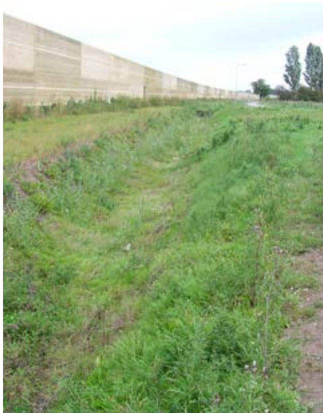
Geluidsscherm langs de Betuweroute (spoorlijn)
