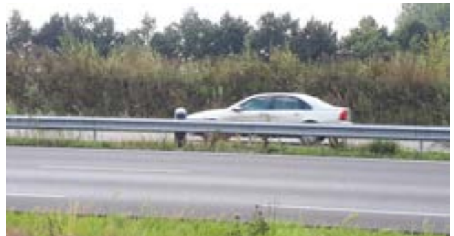
Een lichtkoepel in de middenberm van de N279 gemaakt van een Solartube
