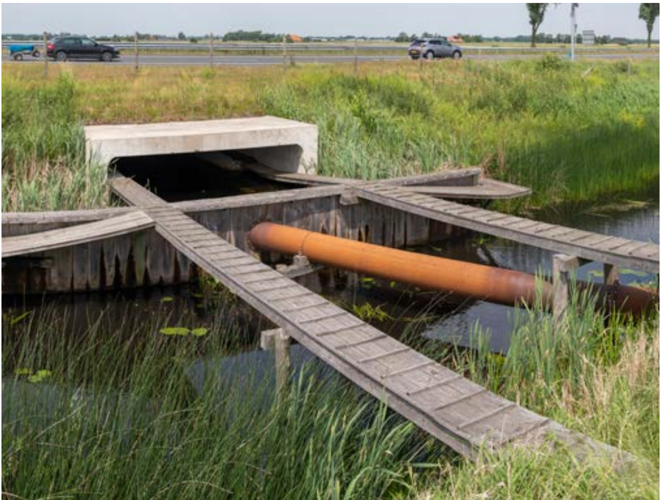
Loopplanken over een sloot richting een faunapassage bij het Koningsdiep (Friesland)
