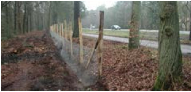
Het raster loopt onder de grond door om te voorkomen dat dieren onder het raster door graven
