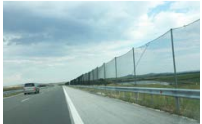
Netscherm langs snelweg in Bulgarije (Bron: Svetlana Miteva)
