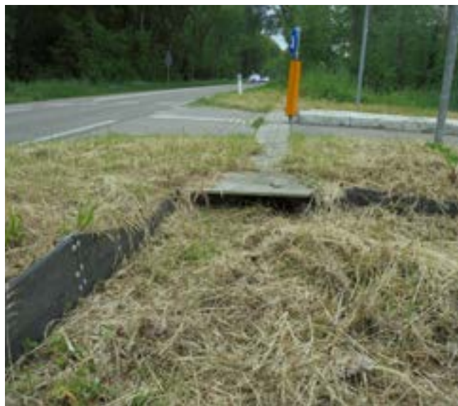
Wel langs scherm gemaaid, maar maaisel laten liggen, zodat dieren alsnog over het scherm kunnen klimmen en tevens de ingang van de tunnel wordt geblokkeerd (Bron: Nico Jonker, Provincie Noord-Holland)
