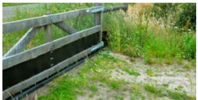
Rubberen flappen aan een werkpoort, zowel onderaan als opzij aan de scharnierkant (Bron: Jan Dirk Buizer, Bureau Waardenburg)
