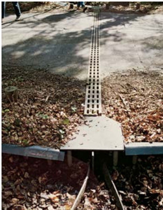
Amfibieëntunnel onder weg
