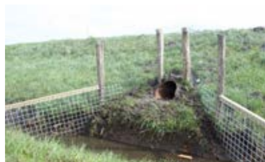
Raster is naar de tunnel geleid, zodat een fuik ontstaat (Bron: Lieveke Crombach, Provincie Overijssel)
