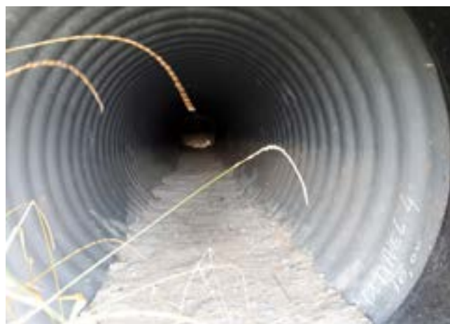
Een laag zand maakt tunnels aantrekkelijker voor dieren (Bron: Johan de Bijl, RWS)
