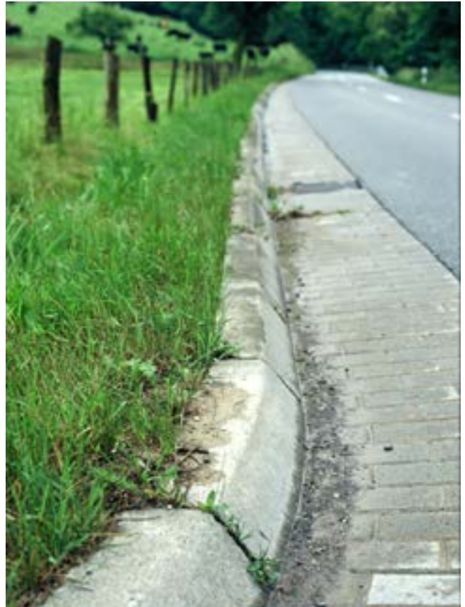
Trottoirbanden die mogelijk valgevaar opleveren voor kleine dieren
