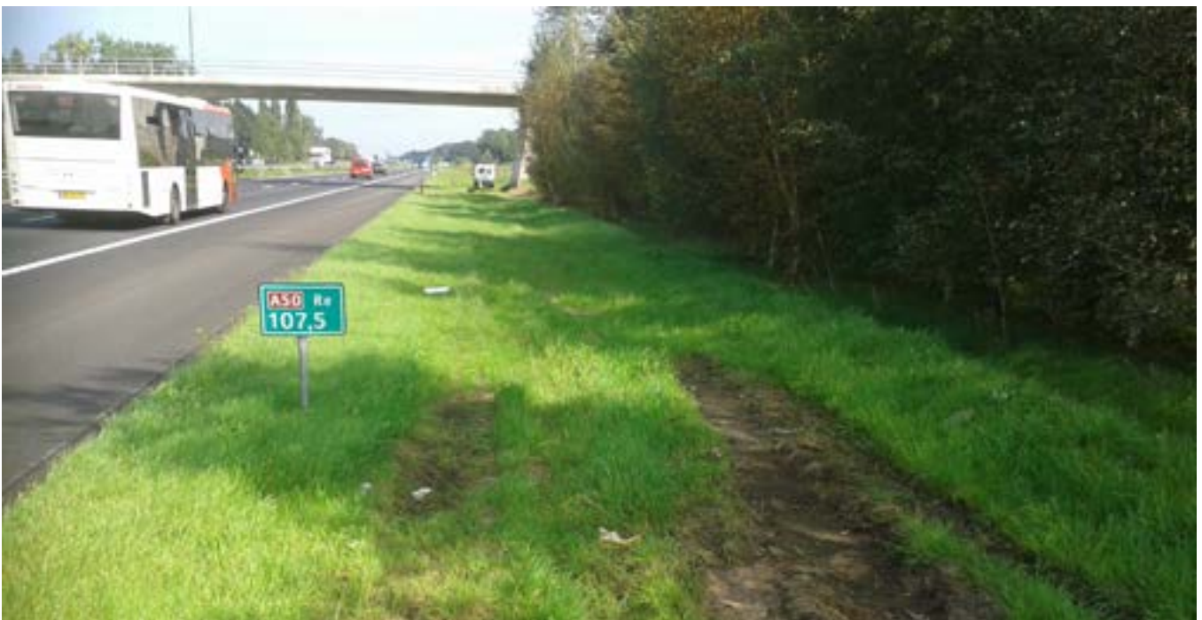
Voorkom inspring tijdens werkzaamheden in de berm (Bron: Paul Boddeke, Bureau Waardenburg)
