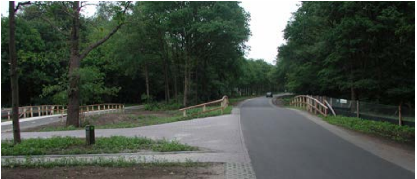
In de middenberm van deze weg is een kuil gemaakt zodat hier licht bij de tunnel kan komen of een open, uitgerasterde loopstrook de twee tunneldelen verbindt (Bron Bert Stegehuis, RWS)
