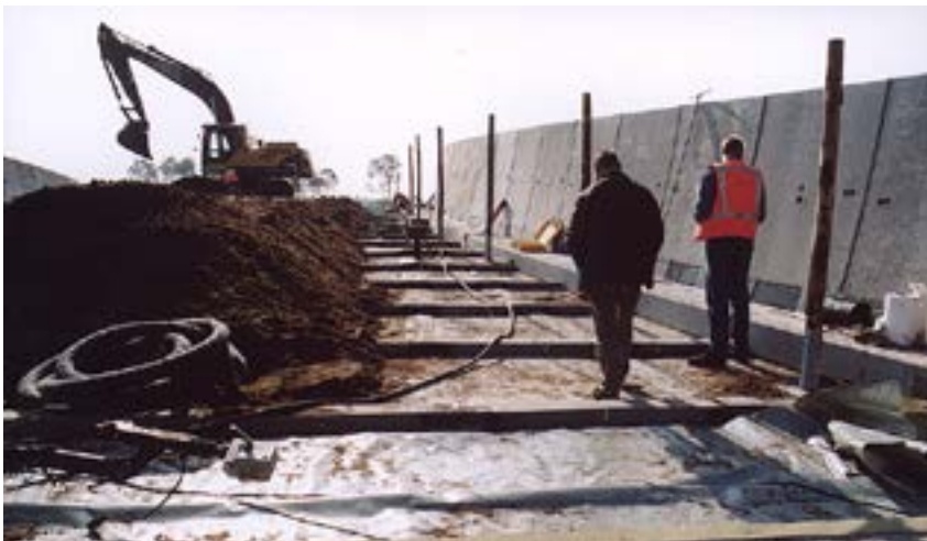
Boven op het ecoduct zijn betonbalkjes gelijmd om water vast te houden, zodat vocht langer beschikbaar blijft voor de begroeiing (De Borkeld, A1)
