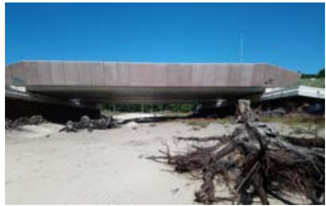
Stobben naar en onder een grote faunatunnel zorgen voor dekking en geleiding en leveren aan kleine dieren, zoals muizen en reptielen, (tijdelijk) leefgebied (Bron: Johan de Bijl/RWS)
