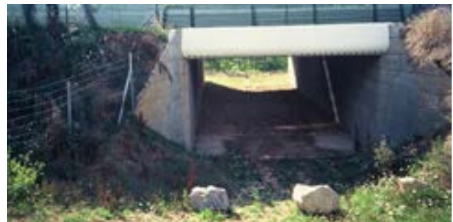
Keien voor de ingang van een grote faunavoorzieningen moet gebruik door landbouwmachines voorkomen
