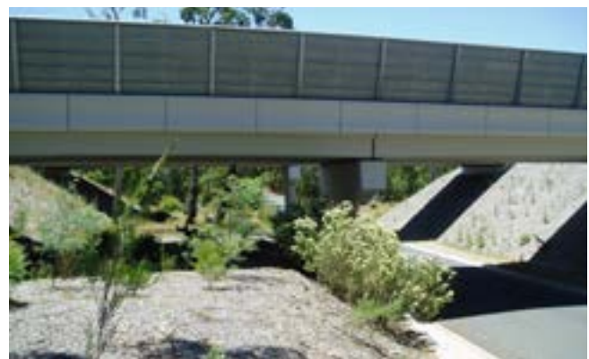
Onderdoorgang in twee stappen (Australië)
