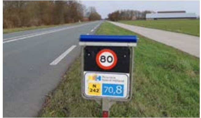
Roller op hectometerpaaltje ter voorkoming dat vogels hierop gaan zitten (Bron: Jasja Dekker Dierecologie)
