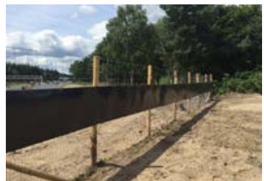
Boommarterkering in de vorm van een HDPE-plaat op raster bij de A12. Door de plaat hebben de marters geen grip en kunnen marters er niet overheen klimmen (Bron: Arfman)
