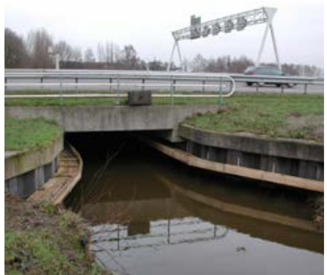
Viaduct met faunavoorziening in Cattenbroek (provincie Utrecht)
