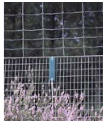
Kleine faunavorzieningen zijn soms door overwoekerende vegetatie niet makkelijk te vinden. Markeringen aan het raster kunnen het vinden van de voorziening vergemakkelijken
