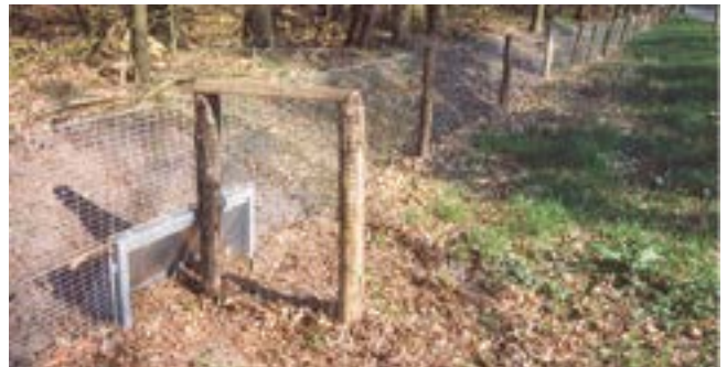
Een terugkeervoorziening voor soorten tot het formaat das/vos
