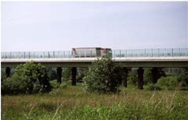
Groot viaduct: weg op palen (Mecklenburg - Vorpommern)
