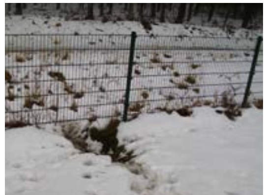
Een reeëngoot onder het hek langs het spoor (Bron: ProRail)
