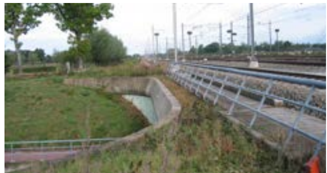
Medegebruik door fauna met behulp van groenstrook op spoorbrug (Bron: ProRail)
