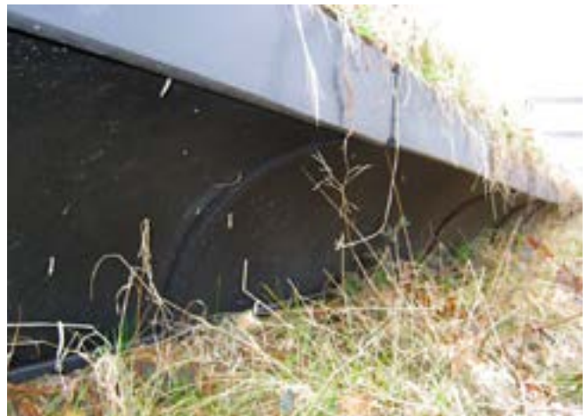
Een gebogen scherm is moeilijker voor kleine dieren om overheen te klimmen
