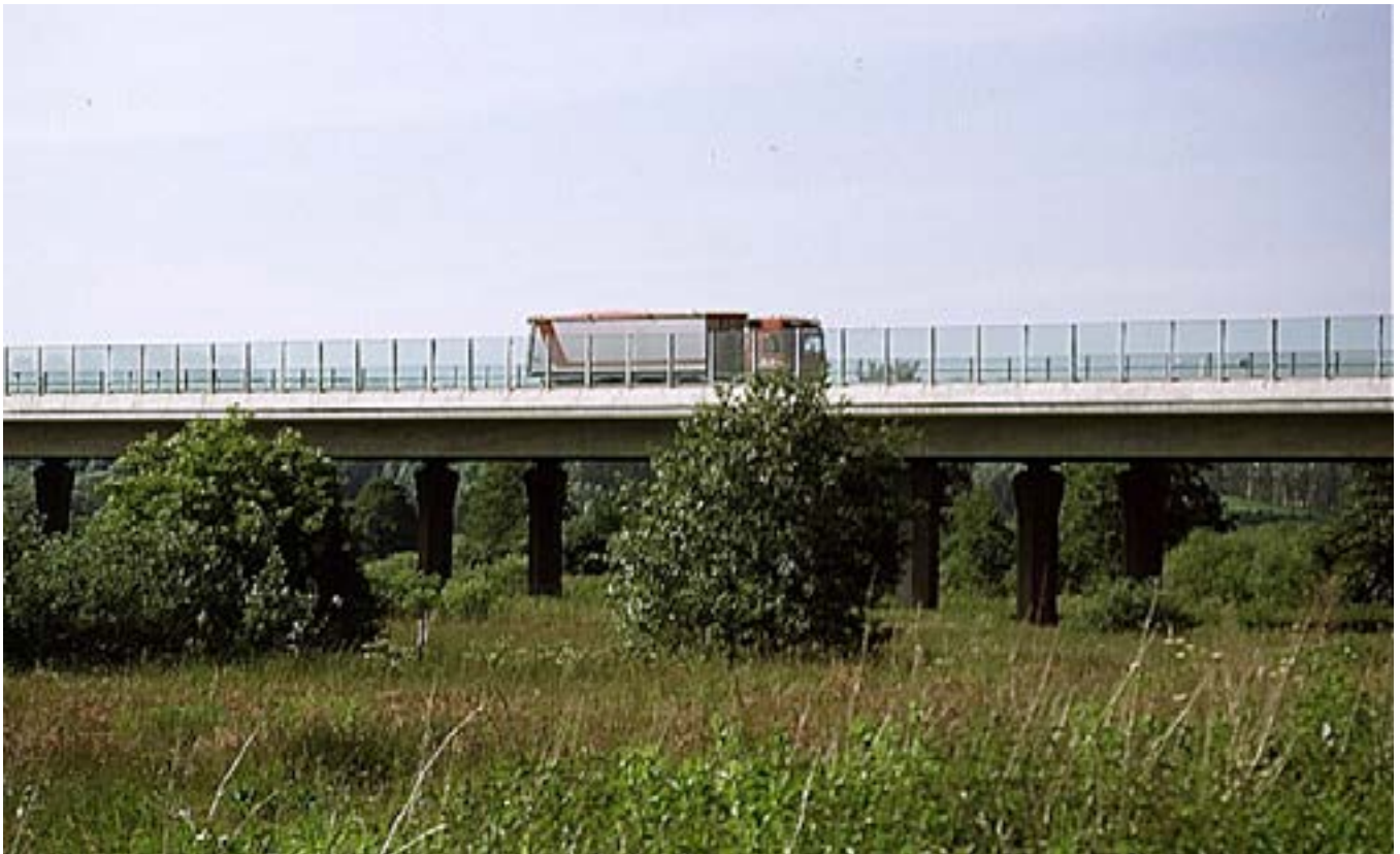
Groot viaduct: weg op palen (Mecklenburg – Vorpommern)
