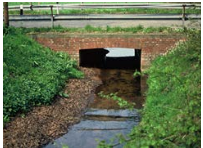
Brug met doorlopende aangelegde oever
