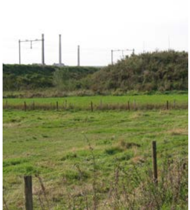
Om te voorkomen dat dassen hun burcht in het talud van het spoor maken, is in de directe omgeving een terp aangelegd met een kunstburcht. (Bron: ProRail)
