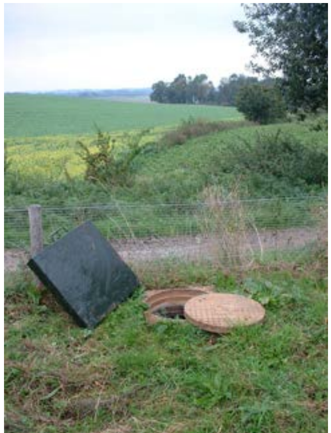
Een open inspectieput als mogelijke valkuil voor dieren
