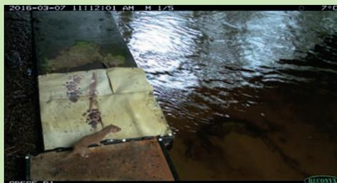
De manière à prévenir l'arrachement de la banquette\* flottante (1), cette solution est déconseillée sur les cours d'eau à forts débits ou dans les ouvrages dans lesquels le cours d'eau peut passer d'un régime lent à un régime torrentiel (ex. : ouvrage en béton lisse, en pente et de section plus petite que le cours d'eau). Elle est également déconseillée dans les cours d'eau connus pour charrier de nombreux embâcles.
