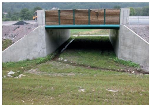
11 Passage inférieur permettant l'évacuation des eaux de ruissellement vers la pente. Source : Cerema.
