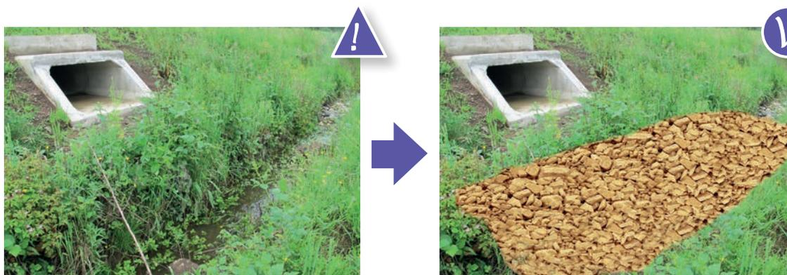
14 Exemple schématique d'un dispositif de franchissement d'un fossé par remplissage de matériaux drainants. Source : Cerema.
