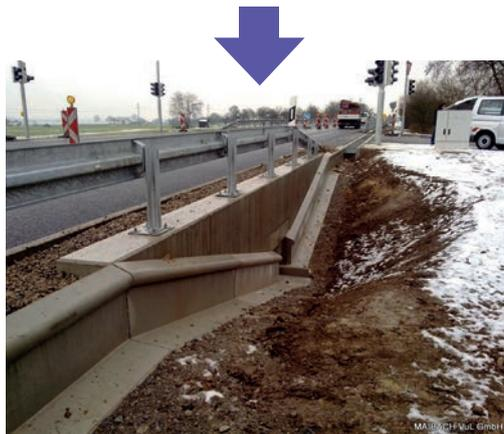
Ouvrage équipé d'une rampe d'accès. Source : Maibach.
