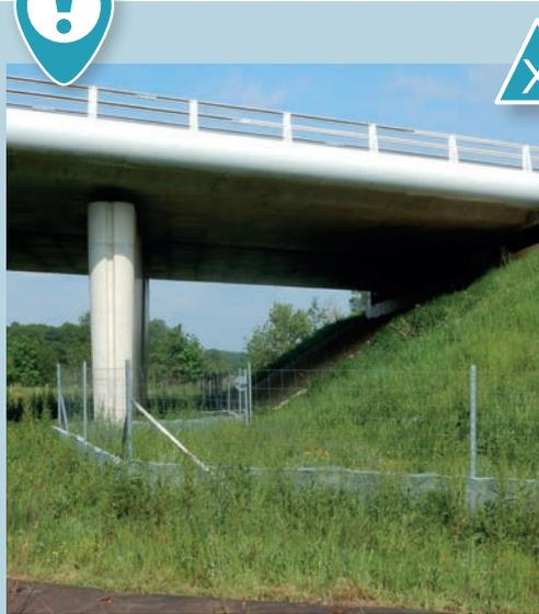
Mauvais raccordement de la clôture qui passe sous l'ouvrage et diminue l'espace disponible pour la faune.
