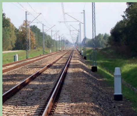
② Poteau UOZ-1 installé le long d'une voie ferrée.
