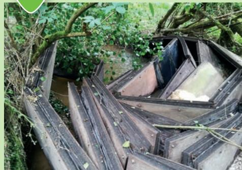
1 Exemple d'un dispositif flottant expérimental installé dans une buse de 85 m emporté par le courant, suite à la rupture de l'ancrage sur la tête de buse. Source : Cerema.
