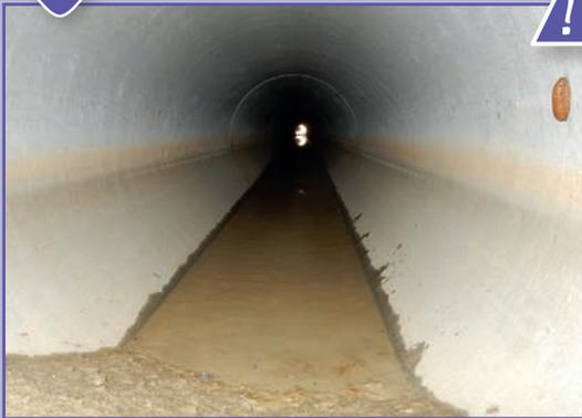
22 Accumulation de matériaux en sortie d'ouvrage empêchant le drainage de l'ouvrage. Source : Cerema.
