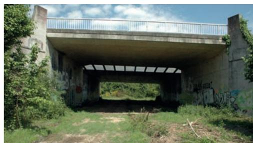
❶ Exemple d'un passage inférieur avec puits de lumière.
