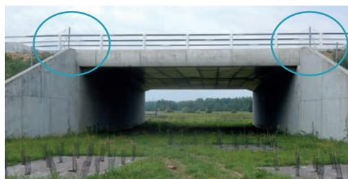
Clôture longeant les murs en retour et raccordée à la rambarde de l'ouvrage.
