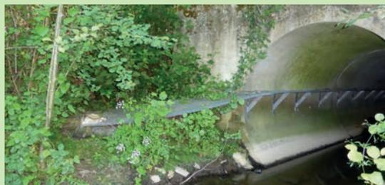
Banquette en plastique recyclé de 50 cm de largeur sur 65 m de long et un tirant d'air de 70 cm. Coût : 15 000 € TTC (2013). RN137 (DIRO). Source : Cerema.
