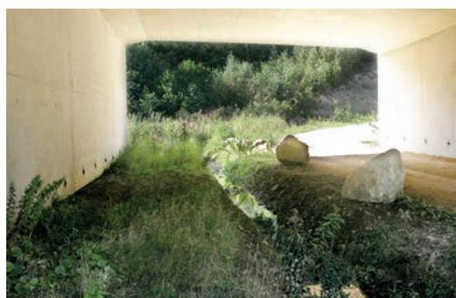
Passage inférieur dont les usages sont séparés par des blocs et le passage d'un cours d'eau (Autoroute A34).
