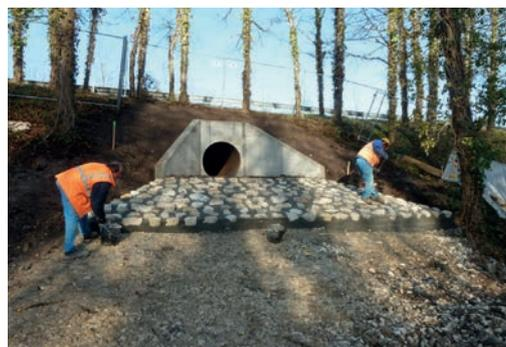
19 Réalisation d'une rampe maçonnée avant recouvrement avec de la terre. Source : Vinci Autoroutes/Réseau ASF.
