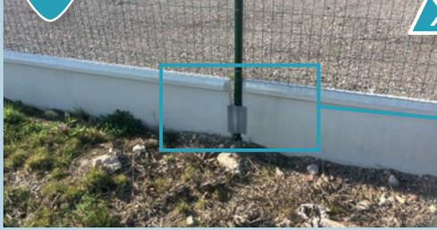
Bassin de traitement équipé d'une barrière béton avec des ouvertures laissant le bassin libre d'accès aux amphibiens. RD 1004 (Bas-Rhin). Source : Cerema.
