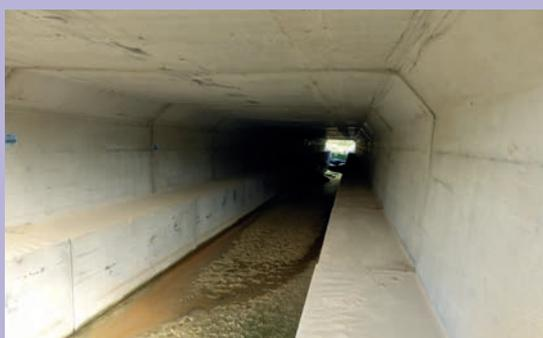
Élément de cadre équipé d'une banquette béton préfabriquée.
