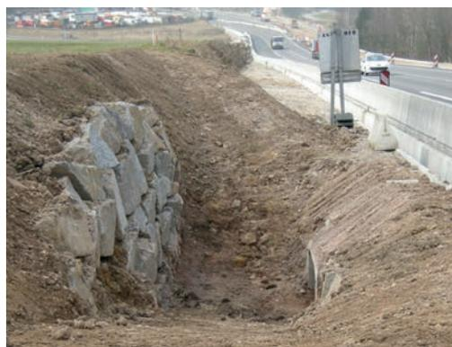
⑦ Rampe d'accès protégée par un mur maçonné côté dépendances vertes. Source : Cerema.
