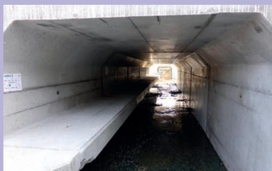
Élément de cadre équipé d'un encorbellement béton préfabriqué.
