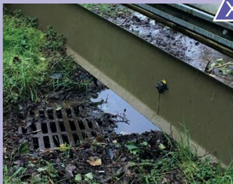
Dispositif de guidage conduisant à un avaloir.
