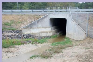
Banquette en gradins (béton).
