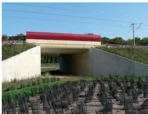
④ Bois de Vigneule underpass fitted with “wing” walls. LGV Est européenne. Source: Néomys.
