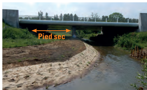
13 Passage mixte hydraulique/faune. Autoroute A304 (Région Grand Est). Source : Cerema.
