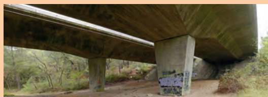
Vallée Chaude viaduct. Source: Vincent Vignon/OGE.
