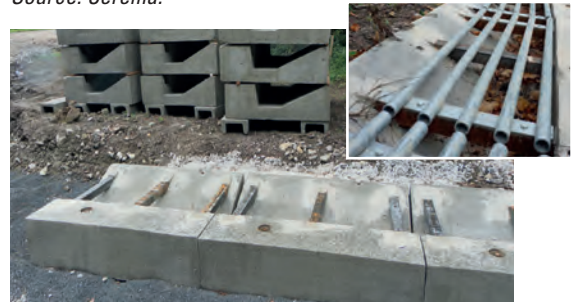
8 Sloping gutter. Source: D'Agostino/Écosphère.
