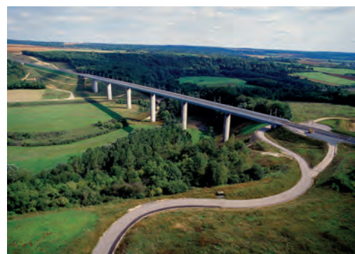
8 Jaulny viaduct (Grand Est Region). LGV Est européenne. Source: RFF (the French rail network)/CAPA/Laurent Rothan (TOMA).
