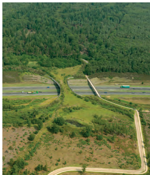
12 Rétablissement agricole dissocié du passage à faune. Source : Luchtfoto Irvin Van Hemert/Pays-Bas.
