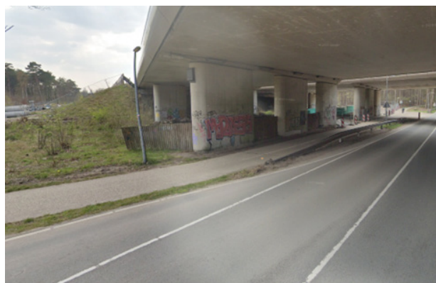
Figuur 5- 12: Ecotunnel Lauwe-Kortrijk E403 © Google Maps
