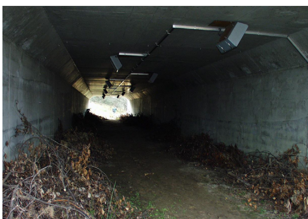
Figuur 10-10: E314 Genk - Ecotunnel Den Teut waar het aanbrengen van takkenwallen de werking sterk bevorderden
