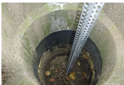
Figuur 3- 17: Voorbeeld van twee in kruisvorm aan elkaar bevestigde stuc-hoekbeschermers die verticaal in een straatkolk werd geplaatst
