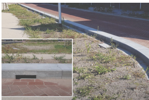
Figuur 2- 4: Bij nieuwe aanleg kan er ook gekeken worden naar infiltratiemogelijkheden in de berm. Op weloverwogen plaatsen kunnen onderbrekingen in de (stoep-)randen het water afvoeren naar de onverharde omgeving in plaats van naar de riolering.
