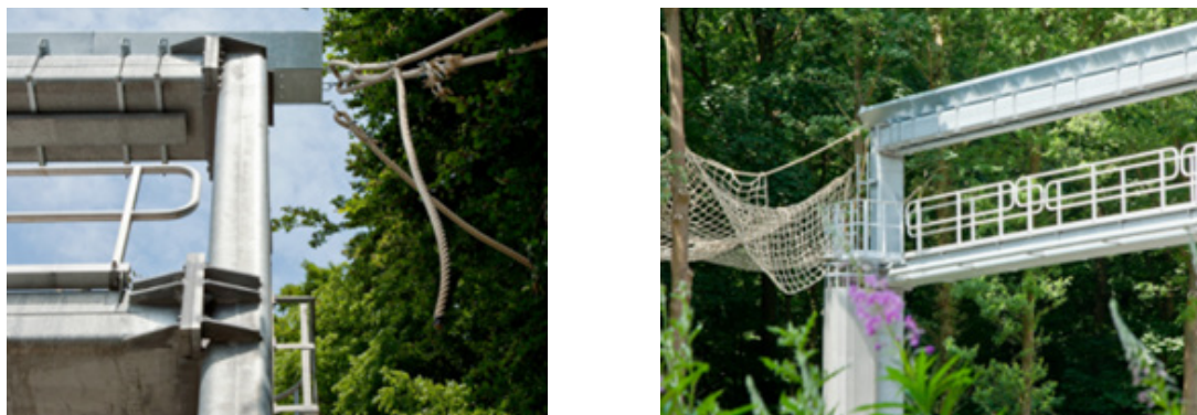
Figuur 6- 4: Boomgoot bovenop portiek over de R0 in Groenendaal (Zoniënwoud)
