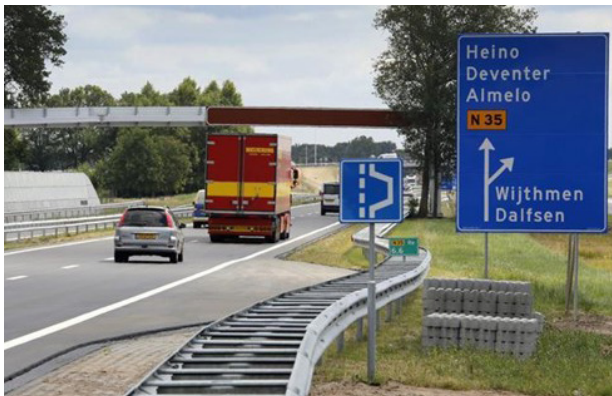
Figuur 6- 6: Vleermuisportaal (N35, Zwolle, Nederland)
