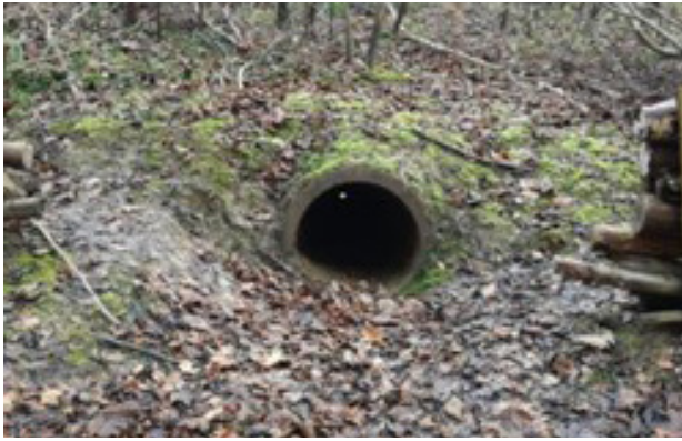
Figuur 4- 6: Twee voorbeelden van ecotunnels in het Zoniënwoud. Op de linkse foto is er onvoldoende aansluiting van een geleiding naar de tunnel, waardoor de ingang moeilijk te vinden is. Op de rechtse foto sluit het raster mooi aan op tunnel, maar is er geen trechterende vorm naar de tunnel, waardoor ook deze moeilijk zal gevonden worden. (bron foto's: https://www.sonianforest.be/ )
