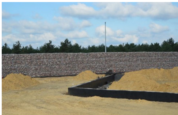
Figuur 8- 14: De buiten- en binnenkant van het afschermend talud op de ecoduct Kempengrens. Op de rechtse foto van tijdens de aanleg zijn ook delen van de compartimentering ivm. de waterhuishouding te zien (Figuur 8-8)
