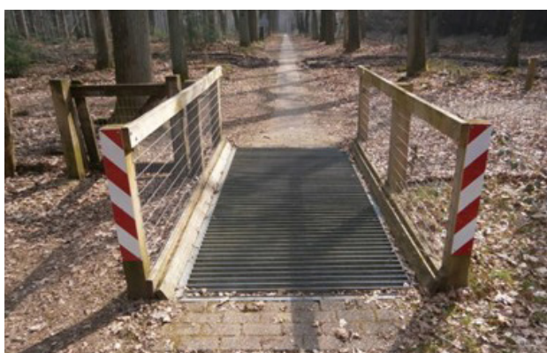
Figuur 9- 43: Voorbeeld van een wildrooster in een fietspad en met een poortje (bron: Arfman)
