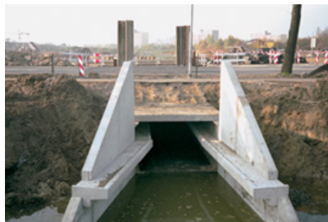
Figuur 4- 11: Voorbeeld van een duiker met betonnen looprichel. Let op het boordje aan de zijde van de looprichels om te voorkomen dat aangebrachte bodem te snel wegspoelt (Bron: Giverbo.nl )
