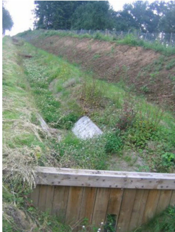
Figuur 2- 17: Stuwen langs de N79 te Tongeren in een gracht met sterke helling.
