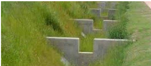
Figuur 2- 14: U-vormige knijpstuw
