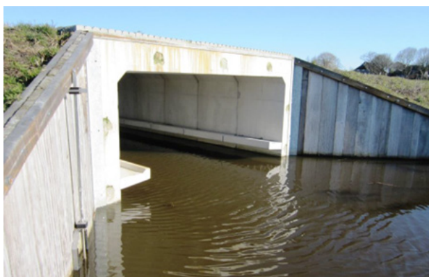
Figuur 4- 15: Duiker met prefab looprichel die helemaal niet aansluit op de oevers, waardoor passage onmogelijk is.
