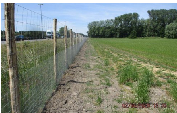
Figuur 9- 16: Een hoog ecoraster gecombineerd met een fijnmazig laag ecoraster naast de E40 in Nevele (bron: verkeerscentrum.be)
