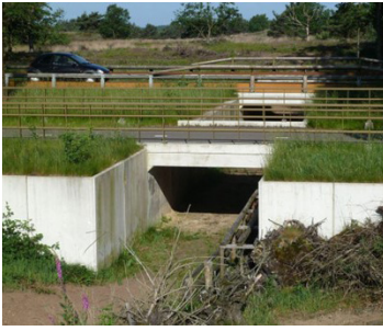
Figuur 4- 42: De faunatunnel bij Elspeetsche Heide waarvan aangetoond werd dat dit wel degelijk gebruikt wordt door reptielen (waaronder adder). Deze is 3m breed en 1,75m hoog. Schuilgelegenheid wordt voorzien door balken en takken.
