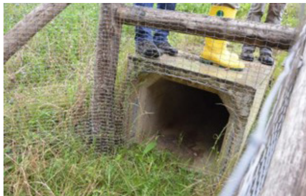
Figuur 9- 3: Kleine ecotunnel aan de N19g te Geel. Goed aangesloten op het ecoraster
