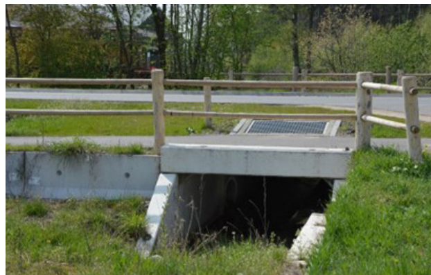
Figuur 4- 8: Voorbeeld van een ecotunnel met een lichtrooster aangebracht tussen rijweg en fietspad
