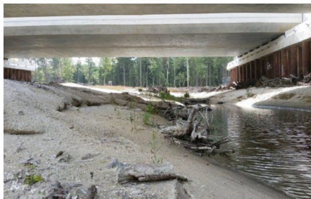
Figuur 5- 5: Een grote onderdoorgang in Nederland (A27 – Hilversum – Utrechtse Heuvelrug) met een natte zone en aangelegde stronkenwal. De smalle opening tussen de wegbanen kan zorgen voor een geluidsverstoring.
