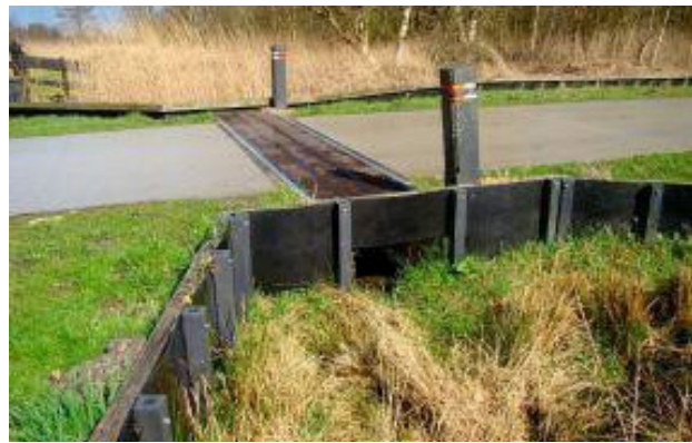
Figuur 4- 45: Een extreem kleine tunnel in het natuurgebied Easterskar (open structuur afgedekt met rooster) waarvan werd aangetoond dat adder en ringslang deze gebruiken. De lengte is beperkt tot 4 m.
