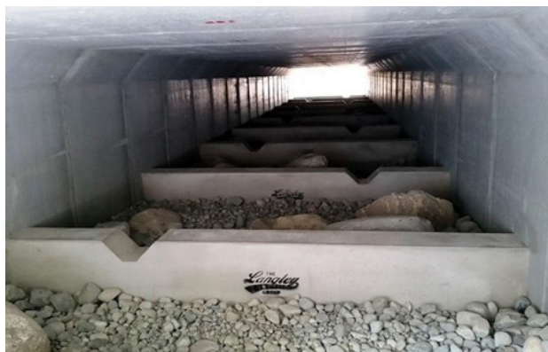
Figuur 4- 27: Voorbeeld van een duiker met daarin een vistrap (zie ontwerp en inrichting).
