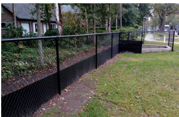
Figuur 9- 11: Laag ecoraster met amfibieënkering (Bredabaan, Wuustwezel). Boven: bron AWV. Onder: aansluiting van het raster op een kleine ecotunnel. Ter hoogte van de ingang ligt een stronk waardoor dieren effectief naar de ingang worden geleid (Bron: Lotte Gielis).
