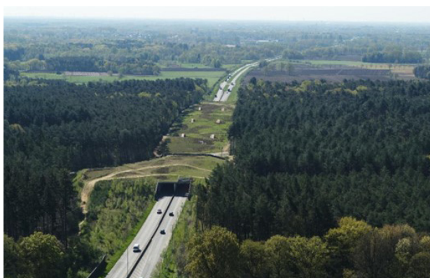
Figuur 8- 1: N19g - Landschapsbrug (490m) te Kasterlee onder de Hoge Mouw in de Heuvelrug tussen Herentals en Lichtaart.
