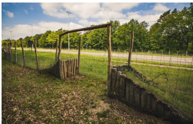
Figuur 9- 35: Voorbeeld van een insprong aan het ecoraster langs de N75 (bron: AWW)
