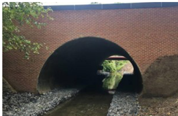
Figuur 4- 23: Voorbeeld van een ecoduiker met doorlopende oevers (Zwalm N454)
