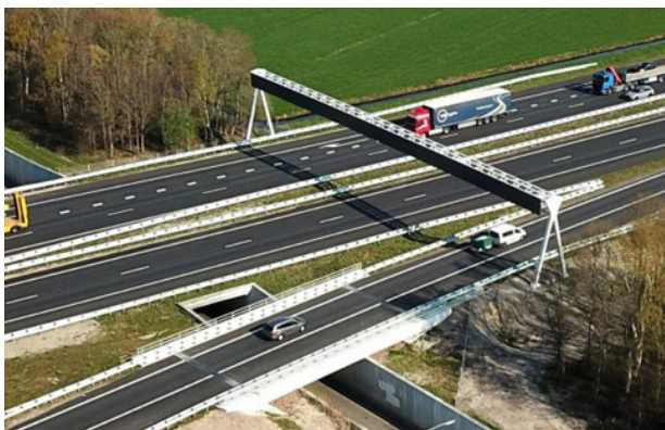
Figuur 6- 8: Vleermuisportaal ter hoogte van knooppunt Joure (Nederland).
