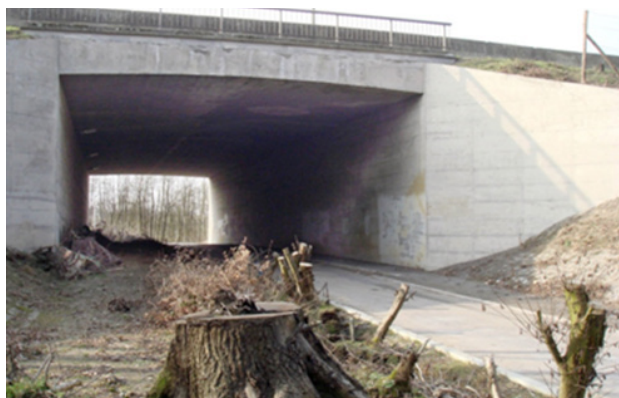
Figuur 5- 9: Een bestaande onderdoorgang aangepast voor medegebruik door fauna in het Zoniënwood.
