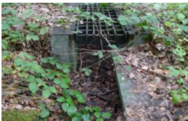
Figuur 9- 26: Goede overgang van een geleidingswand naar een rooster ter hoogte van een zijweg (Bron: Lotte Gielis). Kerkedreef, Brasschaat
