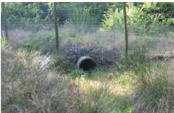
Figuur 4- 7: Voorbeeld van een ecotunnel waar het raster mooi aansluit en er een natuurlijke geleiding is naar de tunnel. Regelmatig onderhoud moet er voor zorgen dat de vegetatie niet te hoog oploopt.
