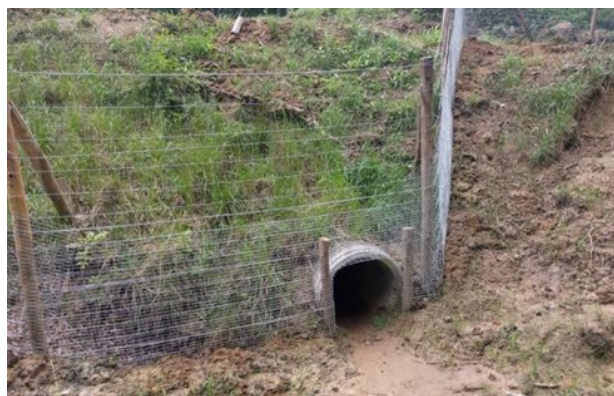
Figuur 9- 15: Laag fijnmazig ecoraster met een correcte aansluiting op een kleine ecotunnel zonder kopmuur onder de RO in Brussel (bron: Bosplus)
