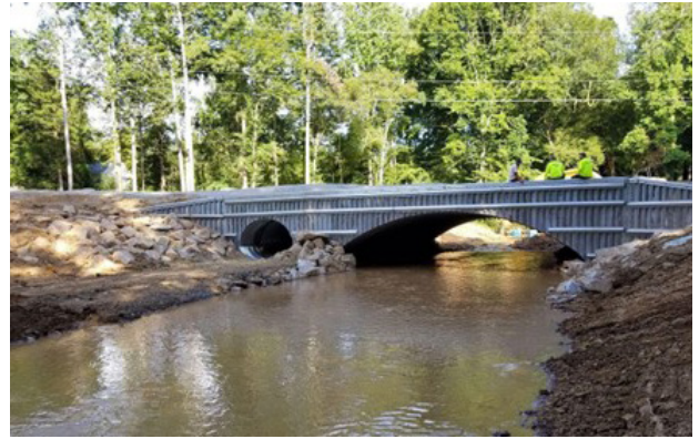
Figuur 4- 22: Voorbeeld van een parallelle ecotunnel. De ruime diameter daarvan maakt dat passerbaarheid veel groter zal zijn dan het voorbeeld van de buizen hierboven.
