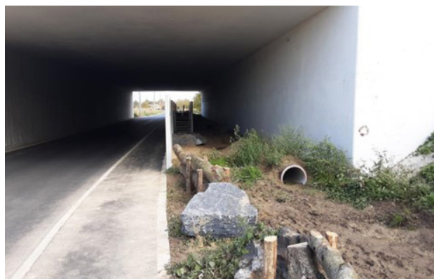
Figuur 5- 11: Tunnel Hellegat onder E314 in Holsbeek
