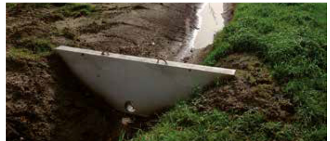
Figuur 2- 15: Debietbeperker - Bron: Waterwegwijzer - VMM
