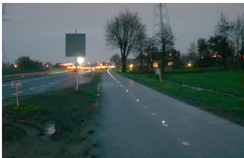
Figuur 3- 2: voorbeelden van retro-reflecterende wegmarkering in combinatie met led wegdekreflectoren. In dit voorbeeld stralen deze nog wel actief licht uit in ongecontroleerde richtingen, ook naar boven.
