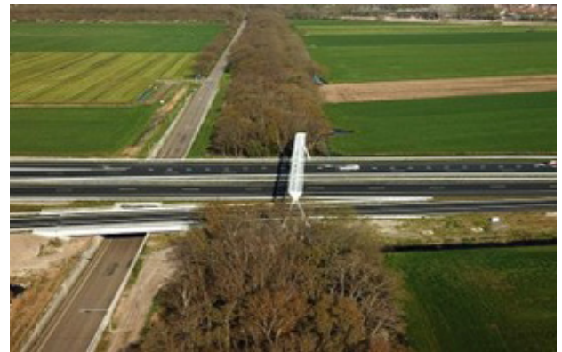
Figuur 6- 7: Vleermuisportaal ter hoogte van knooppunt Joure (Nederland). Het portaal vormt het verlengde van een bomenwal, die haaks op de weg staat.
