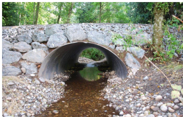
Figuur 4- 28: Duiker waar de natuurlijke stroom van de waterloop eveneens in de duiker voorkomt.
