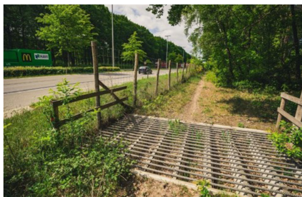
Figuur 9- 42: Voorbeeld van een veerooster met rondstalen roosterelementen die verder uit elkaar liggen dan bij een wildrooster (bron: AWW)
