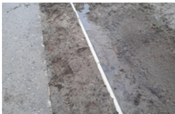
Figuur 9- 27: Voorbeeld van de aanleg van een geleidingswand met een terugkeerwand, met scherpe U-turn, zodat amfibieën terug worden geleid naar de ecotunnel (Witputstraat, Hertselt, bron: Isolde Aelvoet)
