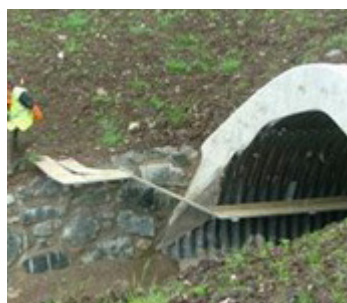
Figuur 4- 14: Looprichels in metalen duikers. De aansluiting op de oever bij het linkse voorbeeld heeft een vrij steile ramp. Het loopvlak op het rechtse voorbeeld is geperforeerd waardoor niet alle soorten er gebruik van zullen maken. Het loopvlak bevindt zich bovendien zeer hoog boven de waterlijn.
