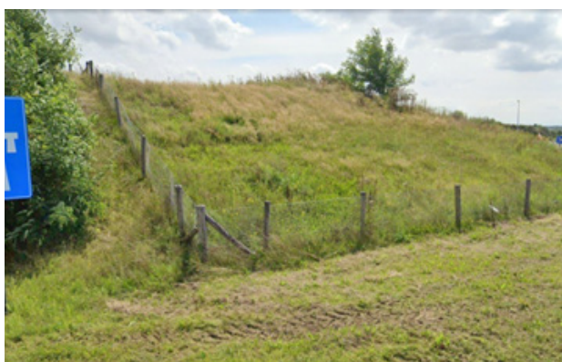
Figuur 9- 18: Laag ecoraster langs de E313 te Tongeren
