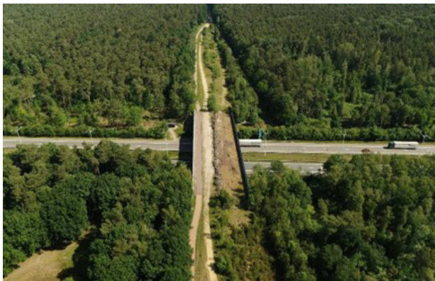
Figuur 8- 21: Ecoveloduct te Genk over de E314 ter hoogte van Nationaal Park Mechelse Heide. Bestaande gewestweg N730 werd gedeeltelijk afgeschaft en de bestaande brug werd omgebouwd tot ecoduct met medegebruik door fietsers, ruiters en meners.
