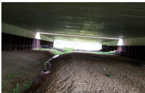
Figuur 5- 7: Onderdoorgang (A12/E35 – Odijk Nederland) met waterdoorlatende bodem en een aangelegde greppel die zorgt voor waterafvoer en extra geleiding.
