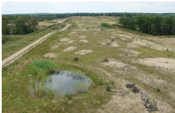
Figuur 8- 22: Ecoduct Zanderij Crailoo (Nederland) met medegebruik door wandelaars, fietsers en ruiters tussen zonsopkomst en zonsondergang, honden zijn niet toegestaan. Aan de noordzijde van het ecoduct is een halfverhard voet-/fietspad (breedte 2,7 m) en een onverhard ruiterspad (breedte 1,6m) aangelegd. Tussen de paden en de rest van het ecoduct is een strook met struweelbeplanting en een circa 1m hoog raster aangebracht ter afscheiding van de recreatieve paden en de natuurzone op de brug (bron: van der Grift et al. 2010, Alterra )
