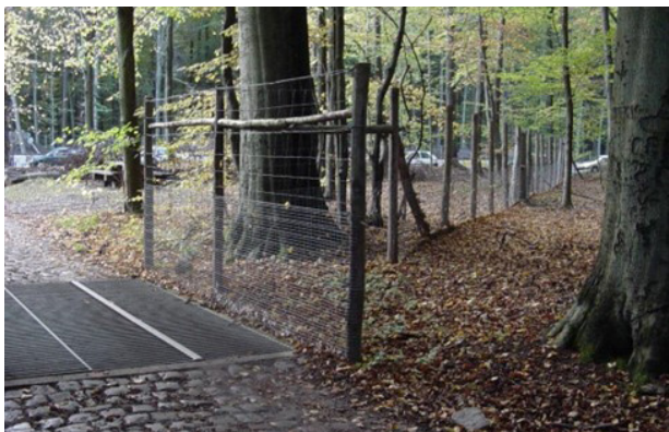
Figuur 9- 39: Voorbeeld van een wildrooster met aansluiting van een ecoraster (Meerdaalwoud) (bron: AWW)
