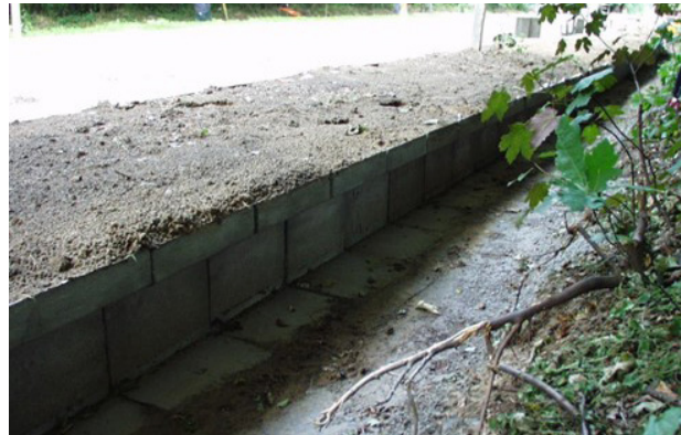
Figuur 9- 25: Goed uitgevoerde geleidingswand (Miksebaan, Brasschaat) waarbij de bovenzijde van de wand gelijk komt met het wegtalud. Daardoor kunnen de amfibieën van op de weg terug achter de wand geraken maar niet omgekeerd. De vegetatie is aan een snoeibeurt toe (Bron: Lotte Gielis).
