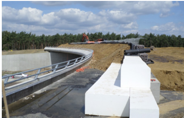
Figuur 8- 13: Opbouw half talud met polystyreen kern en schanskorven op ecoduct Kempengrens
