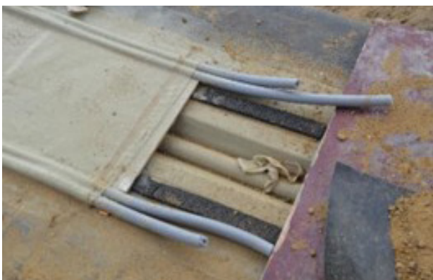
Figuur 8- 4: Voorbeeld van een waterdichte brugvoeg (ecoduct Kempengrens E34 te Postel)
