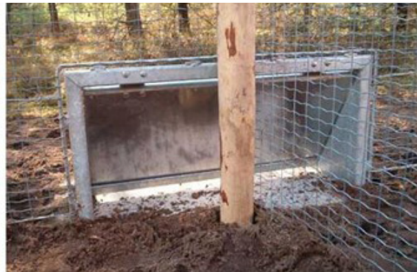
Figuur 9- 32: Voorbeeld van een terugkeerpoort (bron: AWW)
