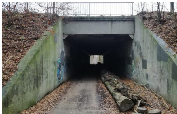
Figuur 5- 13: Een grote onderdoorgang waarbij de faunapassage ondergeschikt is aan de wegfunctie
