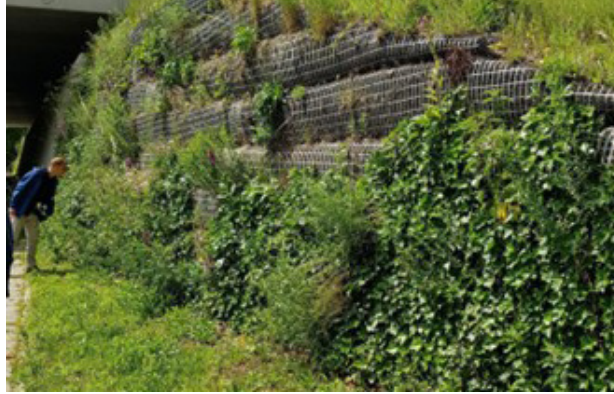
Figuur 5- 3: Voorbeeld van een tunnelingang waar gebruik werd gemaakt van gewapende grond waartegen klimplanten vlot groeien en zo de landschappelijke inpassing verbeteren
