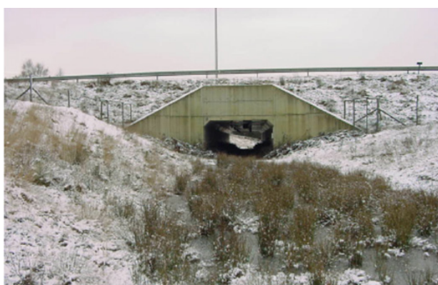
Figuur 5- 8: Grote onderdoorgang aangelegd als koker (E314, tussen DenTeut en Tenhaagdoornheide, Zonhoven). De onderdoorgang wordt gebruikt door zowel diverse zoogdiersoorten als door tal van spinnen- en insectensoorten (bron: Lambrecht & Janssen, 2003)
