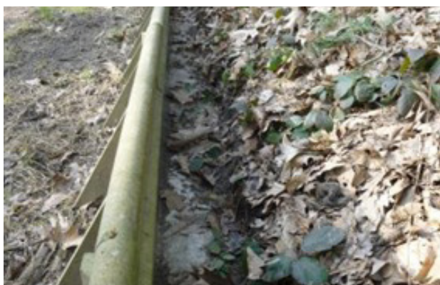
Figuur 9- 28: Een geleidingswand (Huybergsebaan, Essen) waarbij amfibieën die op de weg geraakt zijn, er niet meer overheen kunnen. Dit is dus geen goede constructie (Bron: Lotte Gielis).
