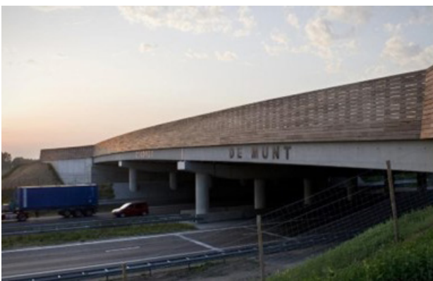
Figuur 8- 11: Houten afscherming op de ecoduct De Munt
