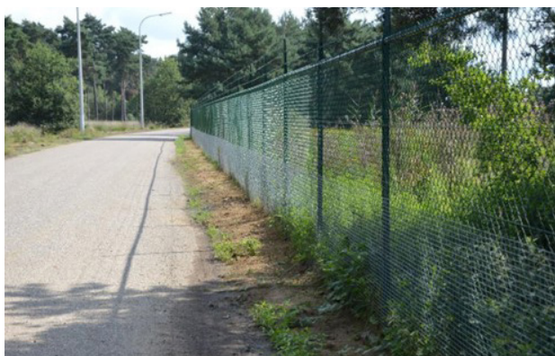
Figuur 9- 14: Laag fijnmazig ecoraster tegen bestaand hoog ecoraster (Kempengrens, bron: AWW)
