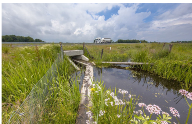
Figuur 4- 17: Doorlopende oever aan een zijde met een loopplank als verbinding over de dwarsende gracht. Een aansluiting op beide oevers werd voorzien. Een antislip laag lijkt te ontbreken op de loopplank.
