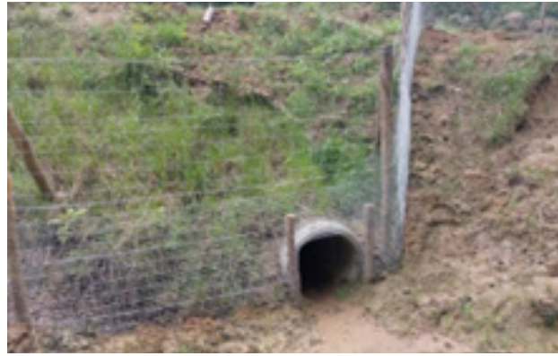
Figuur 4- 6: Twee voorbeelden van ecotunnels in het Zoniënwoud. Op de linkse foto is er onvoldoende aansluiting van een geleiding naar de tunnel, waardoor de ingang moeilijk te vinden is. Op de rechtse foto sluit het raster mooi aan op tunnel, maar is er geen trechterende vorm naar de tunnel, waardoor ook deze moeilijk zal gevonden worden. (bron foto's: https://www.sonianforest.be/ )
