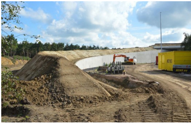
Figuur 8- 15: Aanleg van het geleidend talud naar de ecoduct Kempengrens
