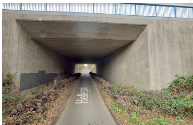
Figuur 5- 10: Pipaenshoek - ecotunnel met medegebruik in het Hallerbos onder de R0/E19 te Halle © Google Maps
