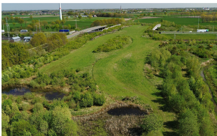
Figuur 10-13: E19 Wuustwezel - Ecoduct De Munt. Aangelegde poelen die mede gevoed worden door het afstroomwater van het brugdek via verdiepte grachtjes.
