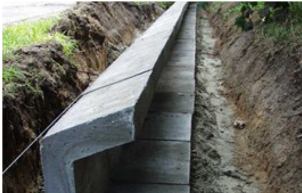
Figuur 9- 24: Verstevigde AWV-geleidingswand eigen ontwerp
