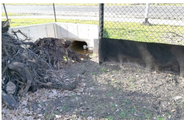
Figuur 9- 11: Laag ecoraster met amfibieënkering (Bredabaan, Wuustwezel). Boven: bron AWV. Onder: aansluiting van het raster op een kleine ecotunnel. Ter hoogte van de ingang ligt een stronk waardoor dieren effectief naar de ingang worden geleid (Bron: Lotte Gielis).
