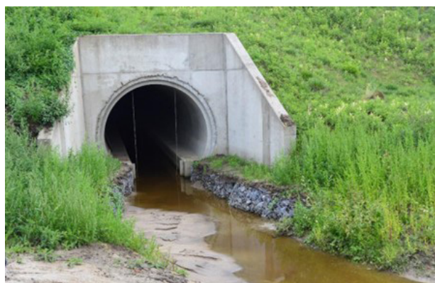
Figuur 4- 16: Ecoduiker waarbij rechts de oever niet mooi aansluit op de richel in de tunnel
