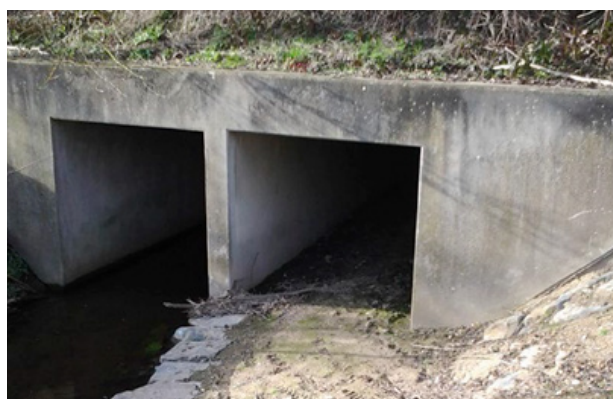
Figuur 4- 20: Een dubbele duiker waar één koker dienst doet als watervoerende duiker en de andere als faunapassage.
