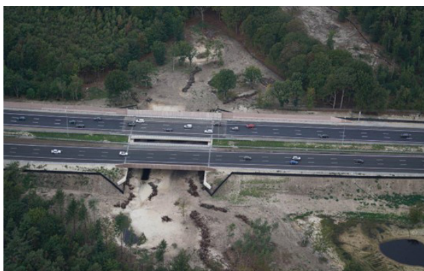
Figuur 5- 6: Bovenaanzicht van de grote onderdoorgang in Nederland ((A27 – Hilversum – Utrechtse Heuvelrug). De stobbenwanden zijn ver genoeg doorgetrokken om de dieren naar de onderdoorgang te leiden. De vegetatie moet zich nog ontwikkelen.
