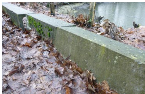
Figuur 9- 31: Wanneer de geleidingselementen niet aansluiten op elkaar, verliest de geleiding (deels) zijn functie. De wand ligt ook niet onder de grond, waardoor terugkeermogelijkheden ontbreken (Miksebaan, Brasschaat ) (Bron: Lotte Gielis).
