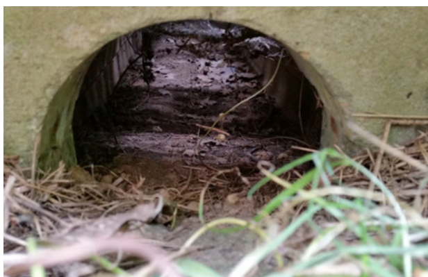
Figuur 4- 37: Gaten in het dak van de tunnel zorgen voor een lichte onderdoorgang.
