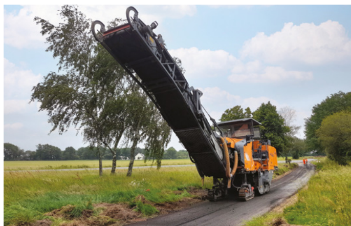
Figure 4-9 : Phase déconstruction (Cerema)
