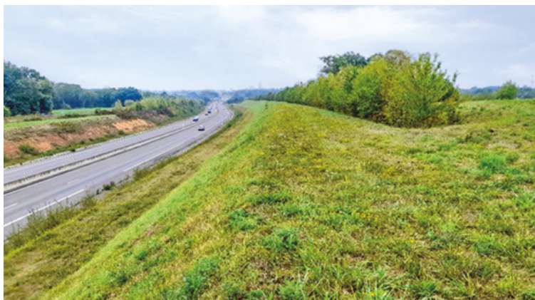
Figure 3-13 : Dépendances vertes routières (Cerema)
