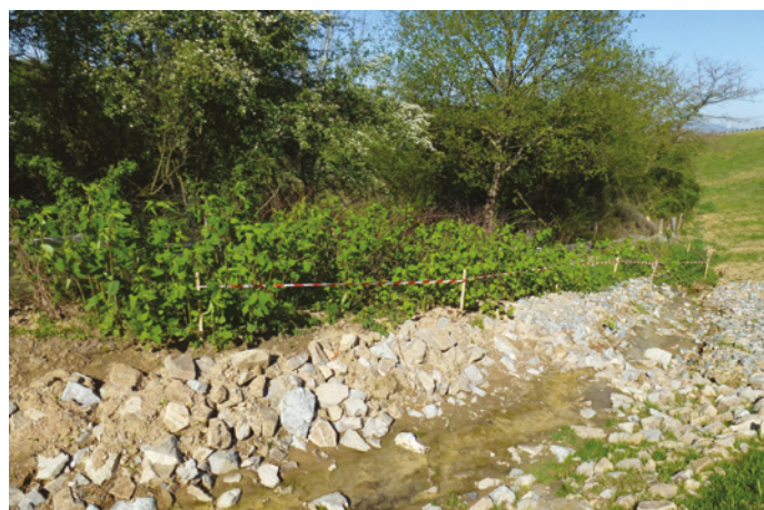
Figure 4-8 : Phase travaux : balisage (J. Biaunier/Cerema)
