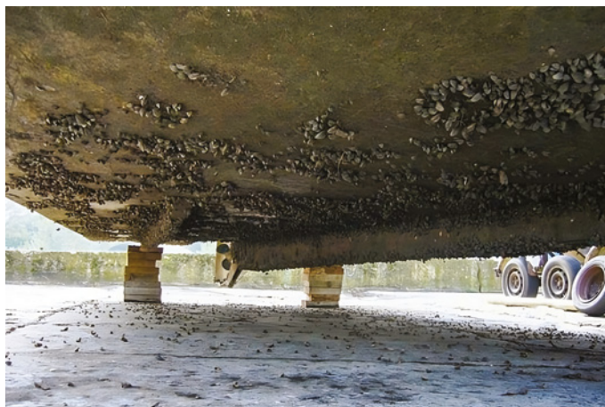
Figure 3-38 : Moules zébrées fixées à la coque d'une péniche (VNF)
