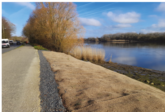
Figure 5-47 : Bâchage végétal ou dégradable renouées (travaux VNF avec accompagnement du CEN Pays de la Loire (Cerema))
