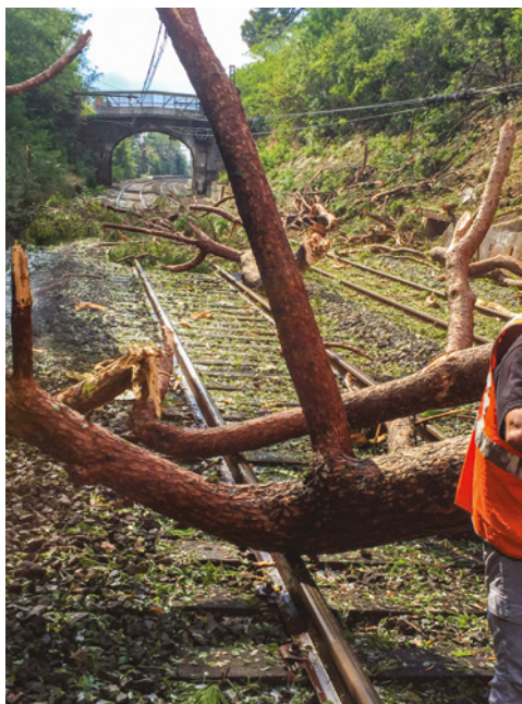
Figure 3-20 : Chute d'arbres sur des voies ferrées (SNCF Réseau)
