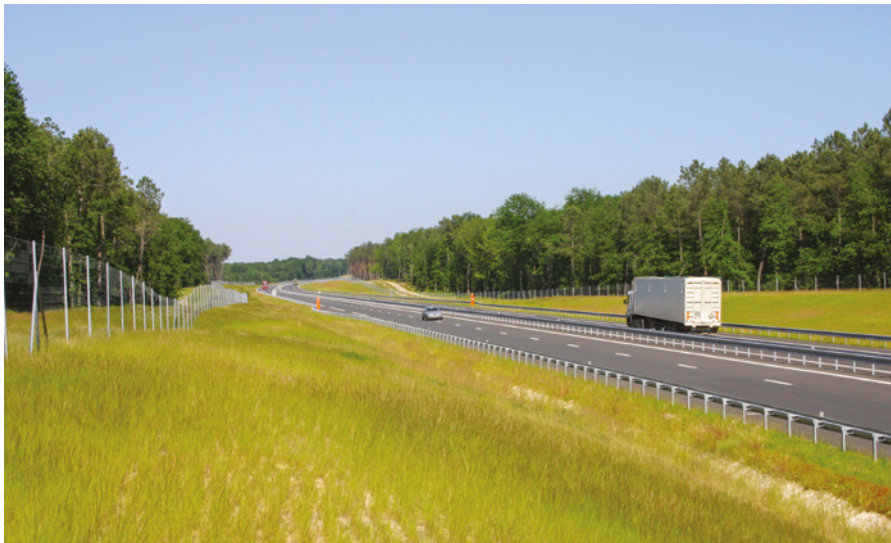
Figure 3-17 : Dépendance verte en cours de végétalisation (Cerema)
