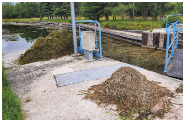
Figure 5-59 : Stockage intermédiaire, ressuyages végétaux aquatiques (VNF)
