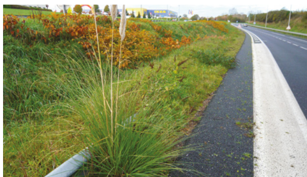
Figure 2-3 : Herbe de la pampa en bord de route (Cerema)
