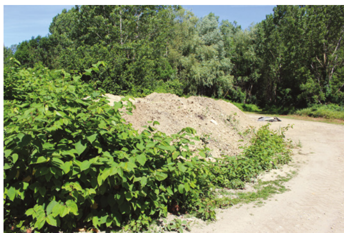
Figure 4-7 : Phase travaux : mauvaise gestion des remblais – mélange terre/renouées (Cerema)
